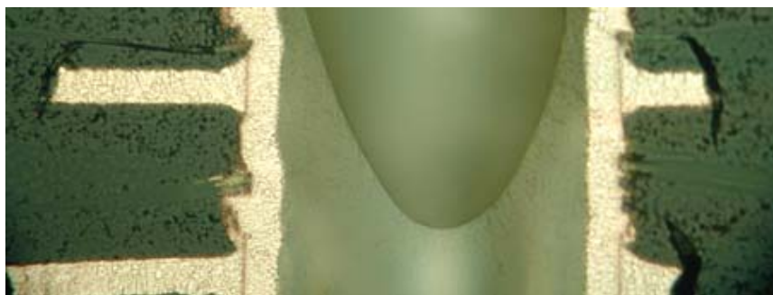
Example of Eyebrow Cracking (D)
